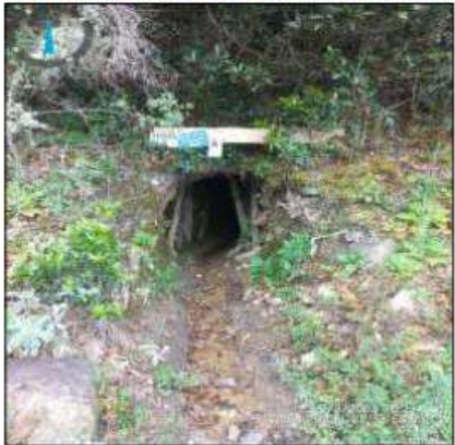
Fotografía No. 3. Frente de explotación No. 2 Túnel 2
